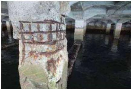
栈橋脚柱部鉄筋露出(48年経過)
