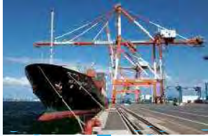
ひびきコンテナターミナル
