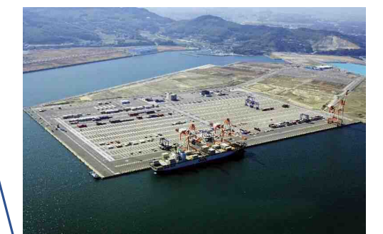
ひびきコンテナターミナル
