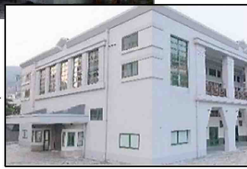
公共上屋を交流施設へ利用転換 (旧大連航路上屋)
