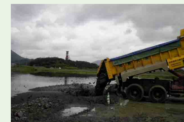
浚渫土砂の受入 (ダンプ車による揚土)
