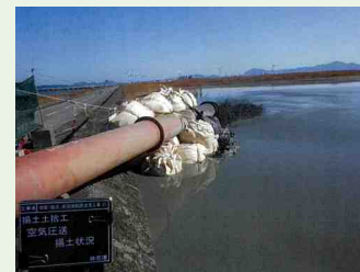
浚渫土砂の受入 (排砂管による揚土)
