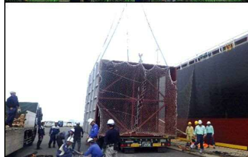
発電所プラント設備荷役
