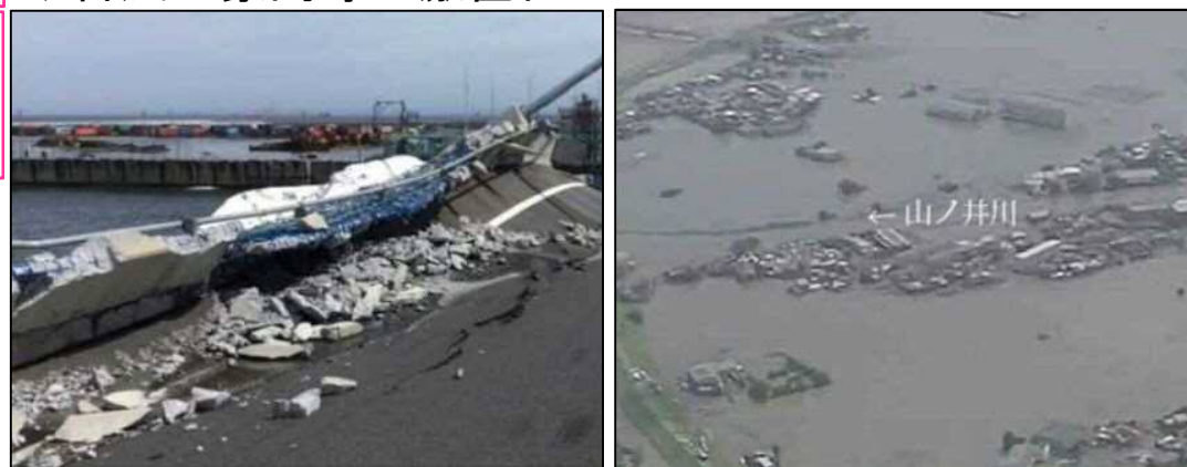
令和元年台風15号による被害 【横浜港・南本牧】
