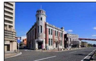
旧古河鉱業若松ビル
