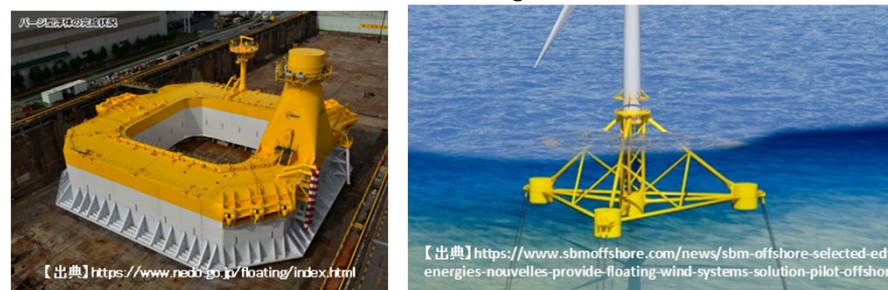
浮体式基礎の例(左:バージ型・右:セミサブ型)
