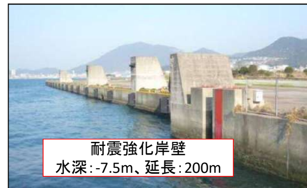
耐震強化岸壁の整備(砂津地区)
