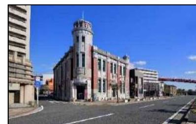
旧古河鉱業若松ビル
