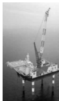
[特殊作業船 SEP] (出典) 五洋建設株式会社
