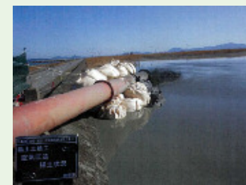
浚渫土砂の受入 (排砂管による揚土)
