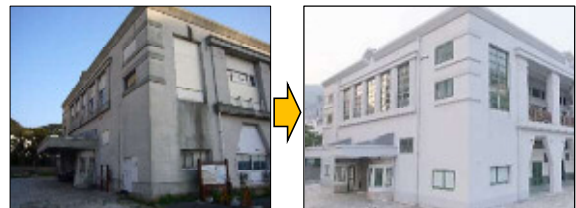
公共上屋を交流施設へ利用転換（旧大連航路上屋）
