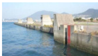
図 2-18 耐震強化岸壁の整備(砂津地区)
