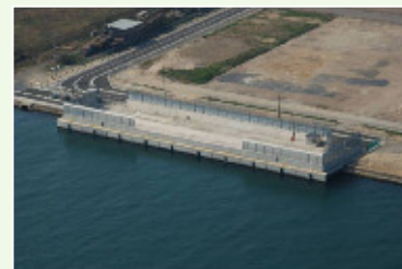
響灘リサイクルポート岸壁
