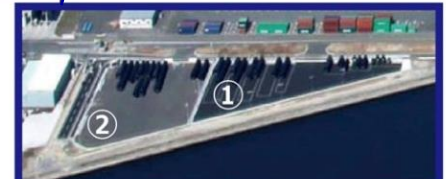
①日通ストックポイント 敷地面積： 8,000㎡ ②ブリヂストンストックポイント 敷地面積： 7,000㎡
