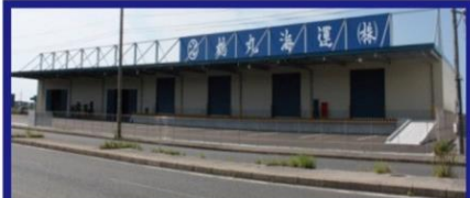
鶴丸海運 ひびき物流センター 敷地面積： 15,753㎡ 延べ床面積： 3,730㎡
