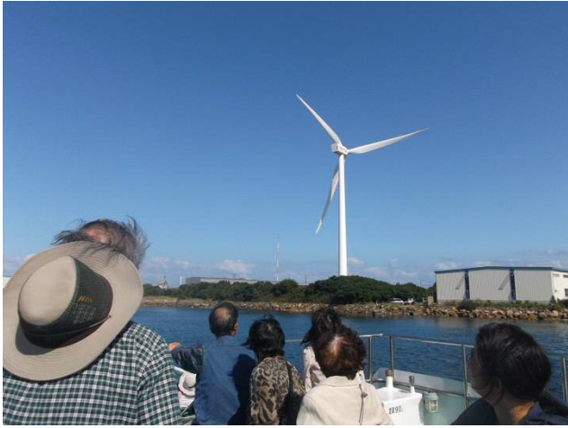
「テトラエナジーひびき」の風力発電機
