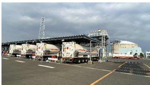
充填の様子(ひびきLNG基地)
